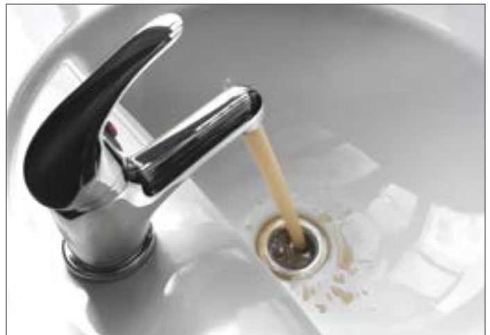
當自來水總管破裂後, 水龍頭流出變色水。
