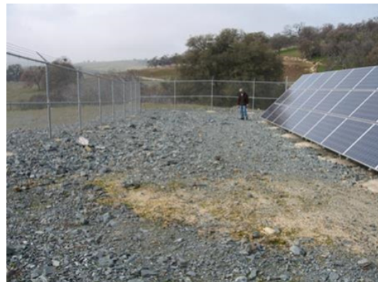
Oakdale Portal Site
