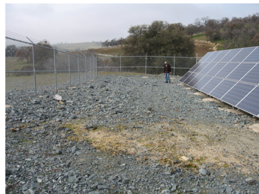
Oakdale Portal Site
