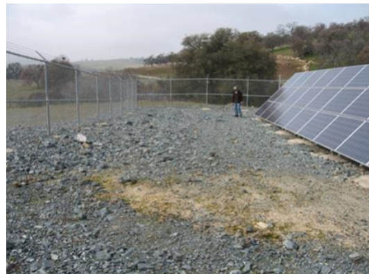
Oakdale Portal Site
