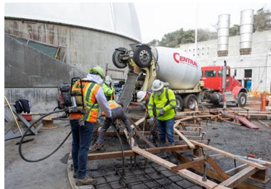
WW-639 OSP741 Digester Gas Holder foundation concrete pour
